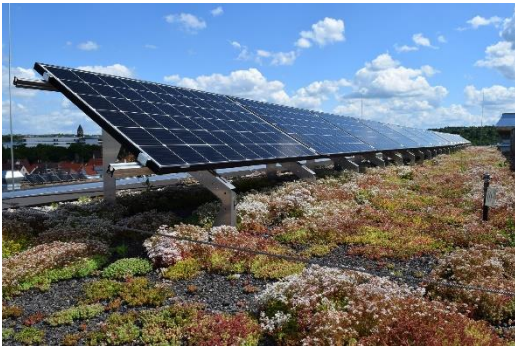
Beispiel einer Kombination aus Dachbegrünung und Photovoltaik
