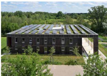
Solar-Gründach mit Ost-West-Ausrichtung
